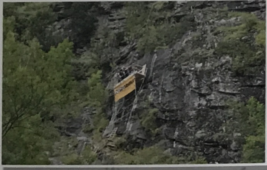
Montage - und Arbeitsgerüst Umlenker
